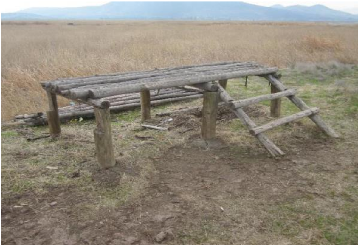
Fotografía 17 Registro de vandalismo en el sector del mirador de Cerámicas Santiago. (Fotografía TNC).
